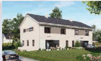
Neubau Doppelhaush. in Mindelstetten 171 m 2 Wohnfl., 6 Zi., 375 m 2 Grund, 1 Stellpl., 1 Carport, voll unterkellert, KfW-55 Ener- gieeffizienzhaus mit Luft-Wärmepumpe, Fertigstellung 06/2026, Energieausweis nicht erforderlich, neu zu errichtende Gebäude gem. § 80 (1) GEG € 614.000,- Keine Käuferprovision!
